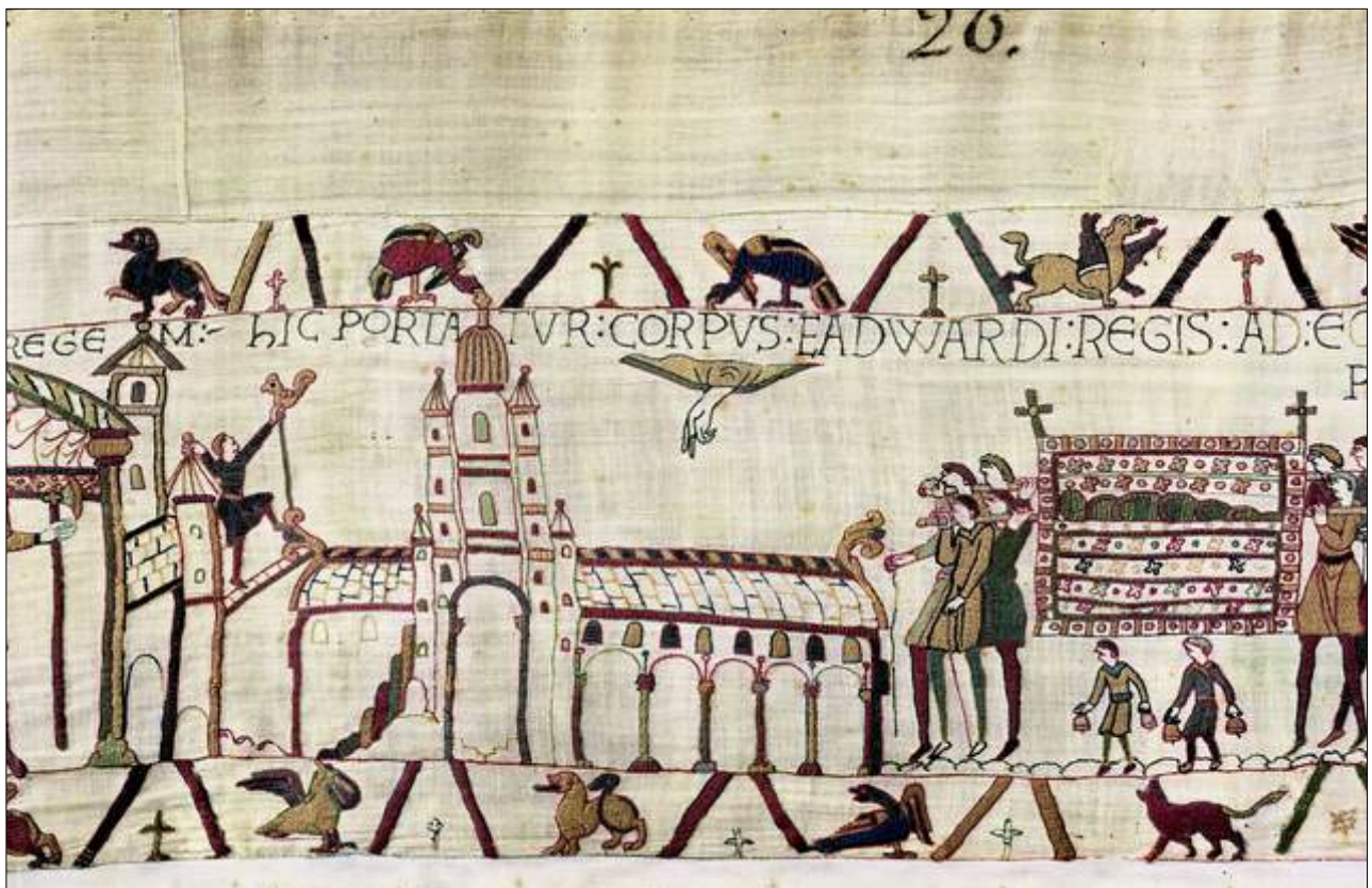
Ici on porte le corps du roi Edouard
